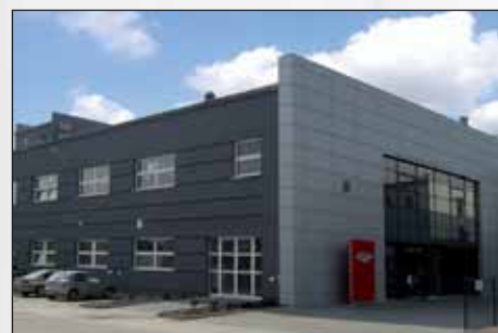
Biurowiec firmy Atrium, Opole
